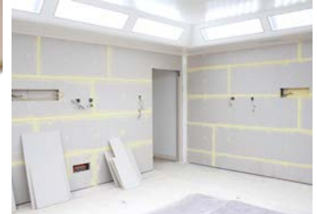
Imagen 16: Instalación de placa radiológica Safeboard.
