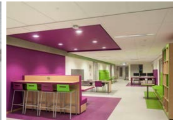
Imagen 4: Aplicación de placa AMF Thermatex® cielo.
