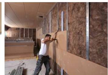
Imagen 8: Instalación Placa Silentboard.
