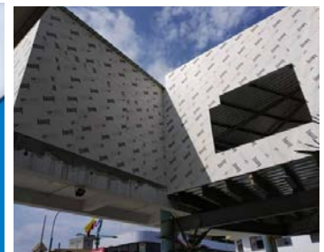
Imagen 2: Instalación placa cementicia Aquapanel® Outdoor.
