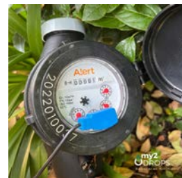
Imagen 5: Sistema ALERT® - Flujómetro con transmisión de datos WIFI.
