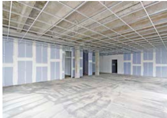
Imagen 14: Instalación de placa Diamant.
